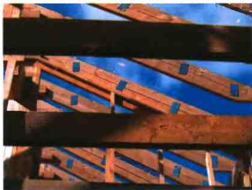
Рис. 33. Пример сращивания стропил
